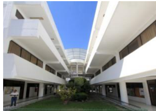
Ilustración 5 Entre edificios FM2 y FM3.
