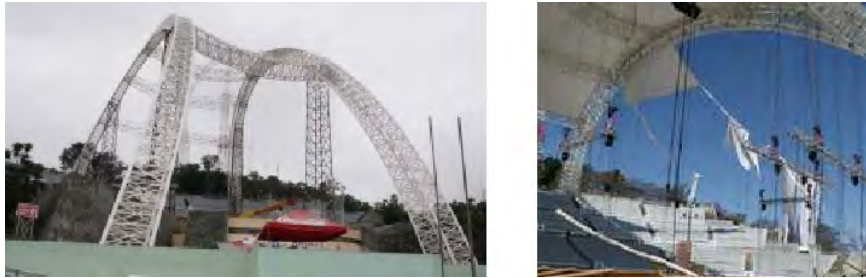
FIGURA 2. Estructura metálica y velaria del auditorio.
